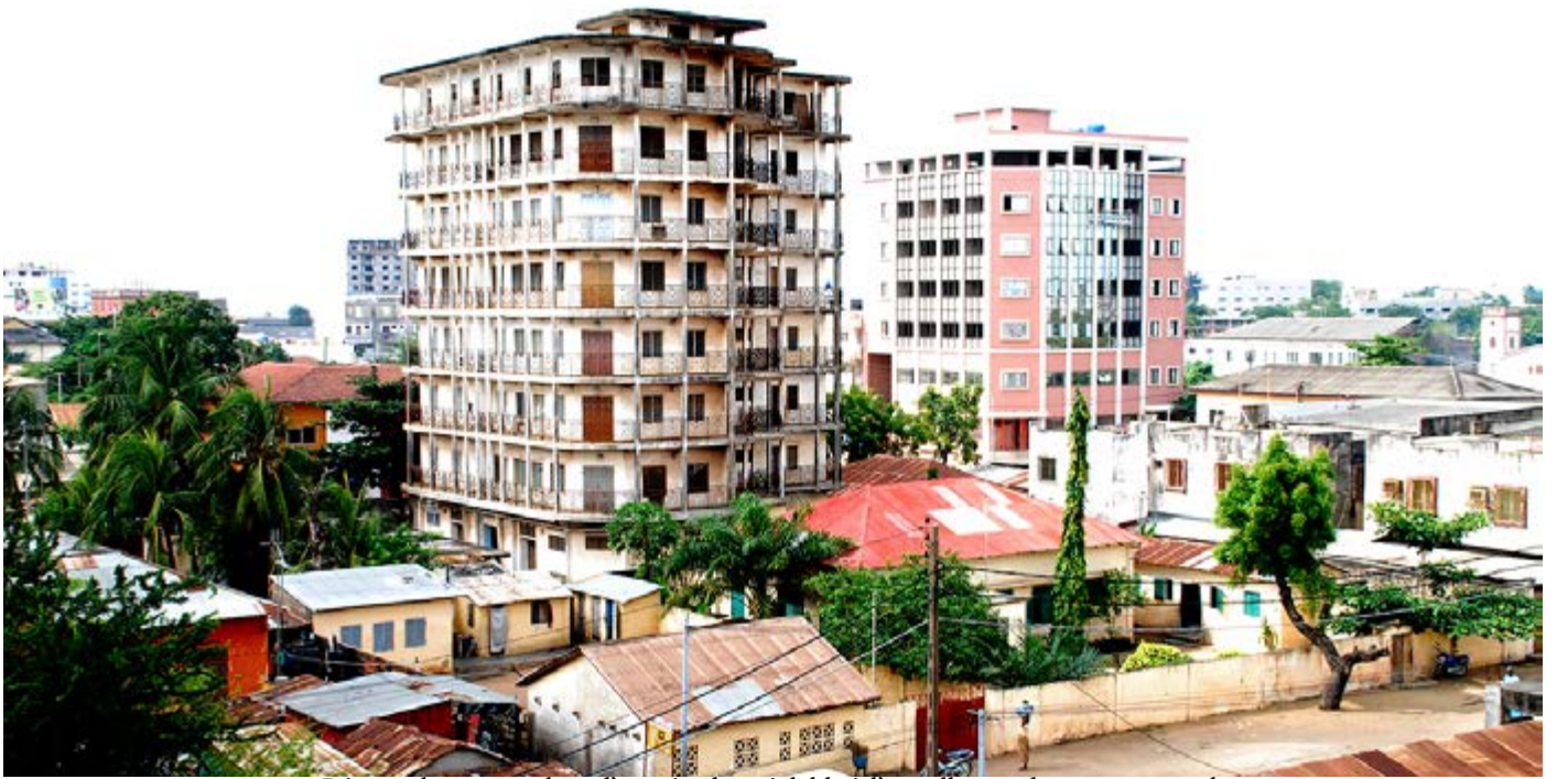
2008, Bénin, photo prise lors d'une étude préalable à l'installation du 118218 sur place.
